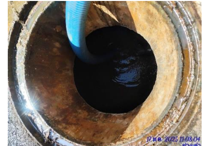
รูปที่ 2-46 สับตะกอนส่วนเกิน เมื่อวันที่ 17 มกราคม 2568 กำหนดสูบน้ำอีกครั้งในเดือน ตุลาคม 2568
