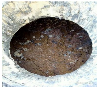
รูปที่ 2-46 สับตะกอนส่วนเกิน เมื่อวันที่ 17 มกราคม 2568 กำหนดสูบน้ำอีกครั้งในเดือน ตุลาคม 2568
