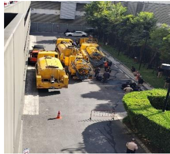
รูปที่ 2-45 ตรวจสอบและทำความสะอาด ลอกท่อระบายน้ำ เมื่อ 29 เมษายน 2568
