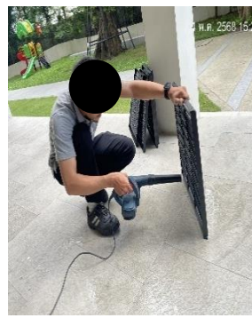
รูปที่ 2-37 ล้างแผ่นกรองและล้างแอร์ส่วนกลาง
