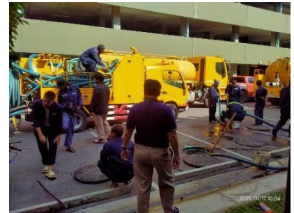
รูปที่ 2-45 ตรวจสอบและทำความสะอาด ลอกท่อระบายน้ำ เมื่อ 29 เมษายน 2568
